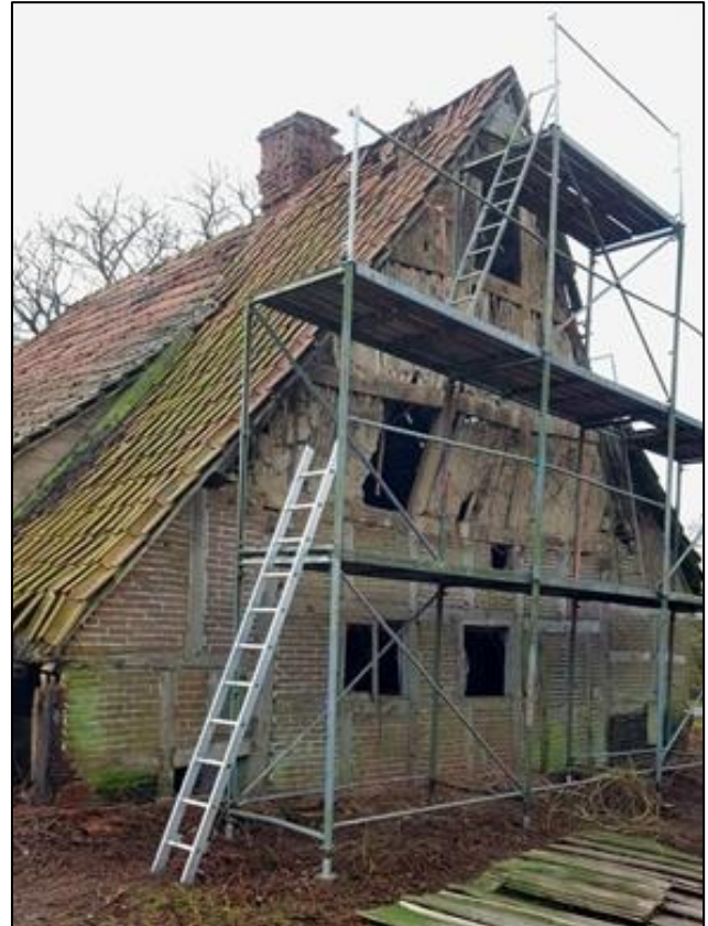
Abb. 4: Der freigelegte Fachwerk-Rückgiebel mit Spuren des früheren Fachwerkschornsteins
