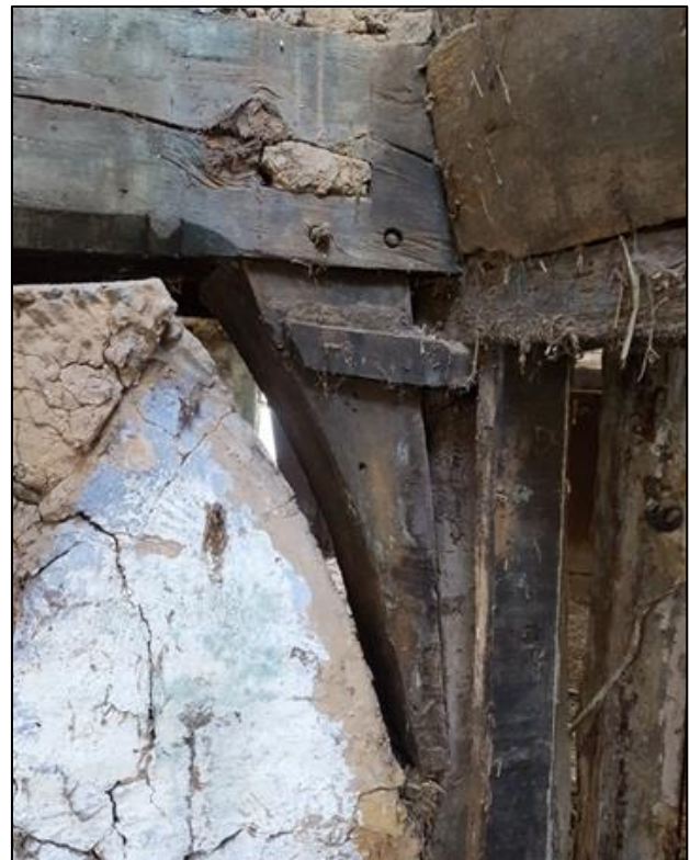
Abb. 2: Luchtbalken mit Knagge und Abfasung mit Fasenstopp, um 1600 (d).
